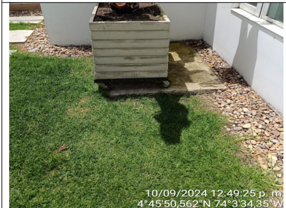
Foto No. 5. Ubicación Trampa de grasas Casa 2.
