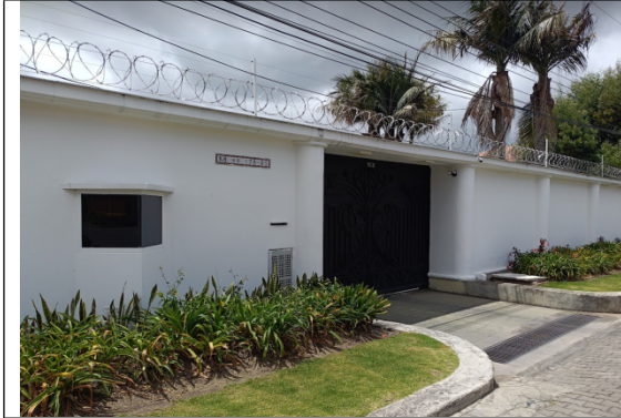
Foto No. 1. Fachada del predio.
