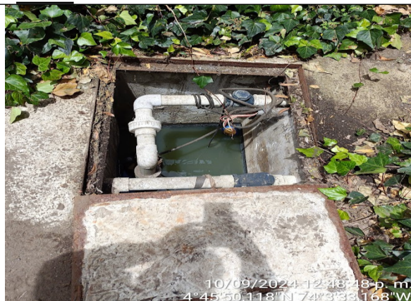
Foto No. 8. Salida ARD a canal a tierra Cra 68
